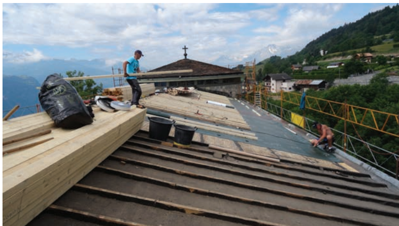
Les ouvriers s'affairent sur le toit.
