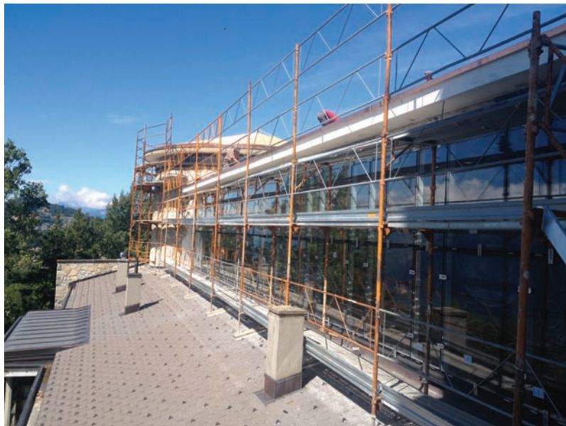
La structure vitrée sud protégeant les vitraux.
